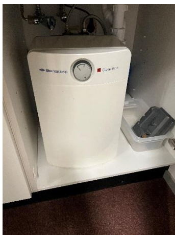
Foto 3. Elektrische boiler.
