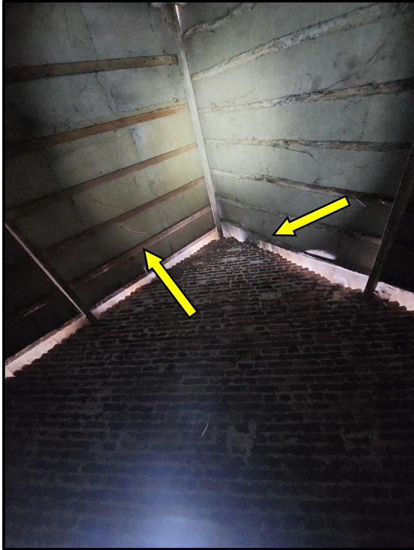
Figuur 5.1 Links: de situatie van de onderzijde van het dak met zichtbaar het dakbeschoot (aangegeven met gele pijl). Rechts: situatie van de boeiboorden met ruimte (zie gele pijlen) tussen de muur waar vleermuizen zich kunnen vestigen.
