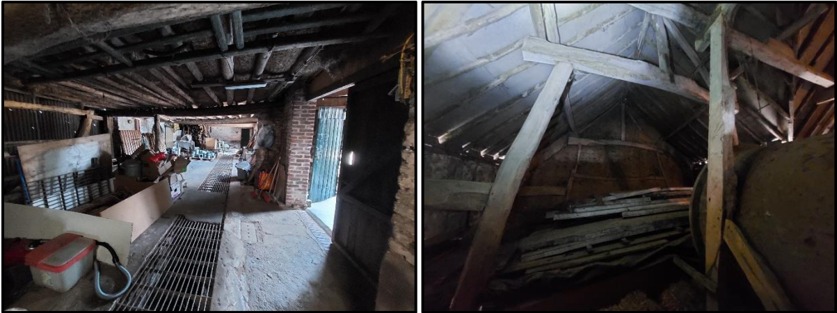
Figuur 2.5 Weergave binnenzijde van de te renoveren grubstal.
