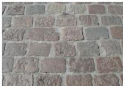
Nr 12+13: Bestrating type 3 Zweedsgraniet in gebonden voegvulling
