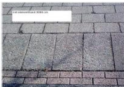
Nr 5: Trottoirband Inritblok
