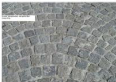
Nr 12+13: Bestrating type 3 Kleinplaveisel in gebonden voegvulling
