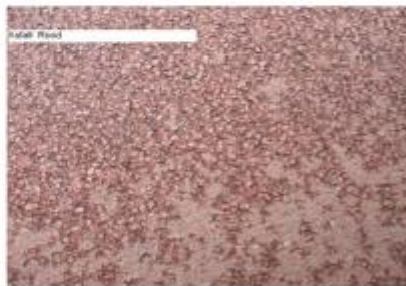
Nr 15: Herstel asfalt rood Rode asfalt
